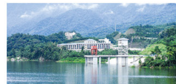
海南省琼中抽水蓄能电站
