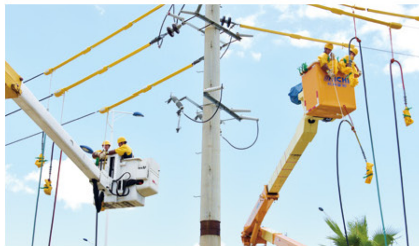
广西电网北海供电局采用带电作业方式对线路进行升级改造
