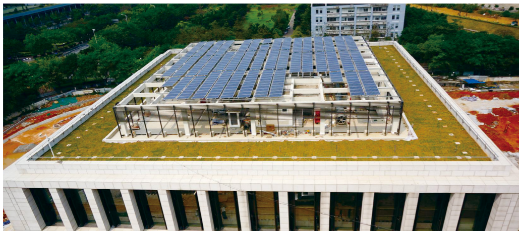
南方电网生产科研综合基地楼顶运用光伏发电
